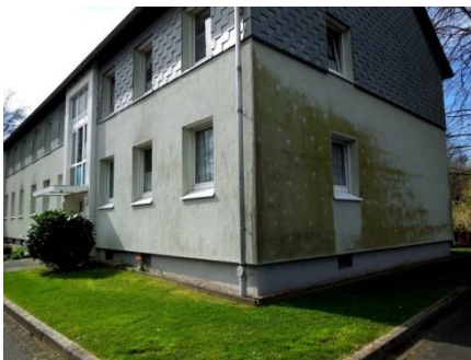
Bild einer über Jahre mit Algen und Moos bewachsenen Fassade in der Schinkelstraße – sowie die anschließende Situation nach Reinigung
